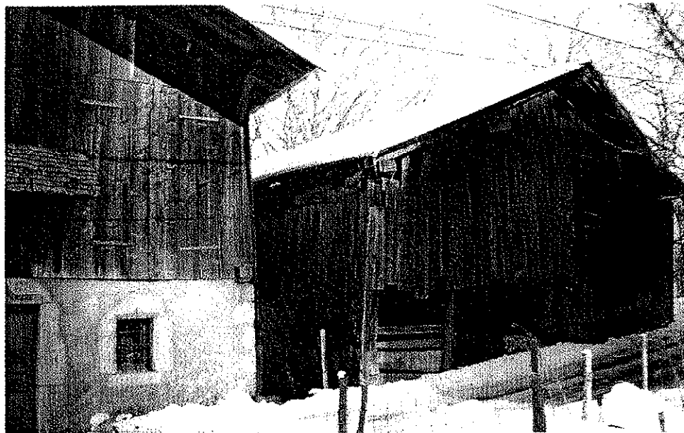
La maison du colporteur, avec à côté le grenier, dissimulé par une remise.
